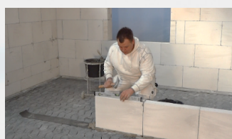
Multipladen® hleðslusteininn, 10 x 40 x 60 cm, er komið fyrir og því næst er hann stilltur af þannig að hann sé bæði hornréttur og í lóði.
