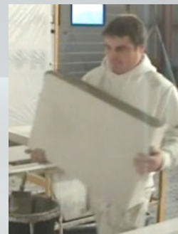
Multipladen® hleðslusteini í 3. og 4. röð komið fyrir.
