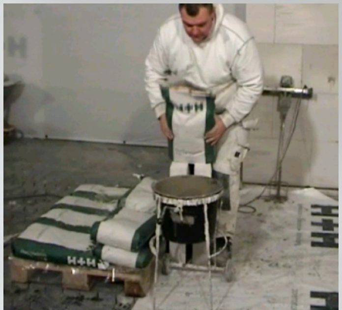
Einum eða fleiri límpokum er lyft af tveimur mönnum af lágu bretti og þeir settir á fast undirlag. Þá er pokinn opnaður og lími hellt í límfötuna.
