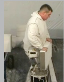
Multipladen® hleðslusteini í 2. röð komið fyrir.
