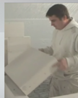
Hægt er að leggja neðri hlið Multipladen hleðslusteinsins á ská á vegginn og lyfta svo á sinn stað.
