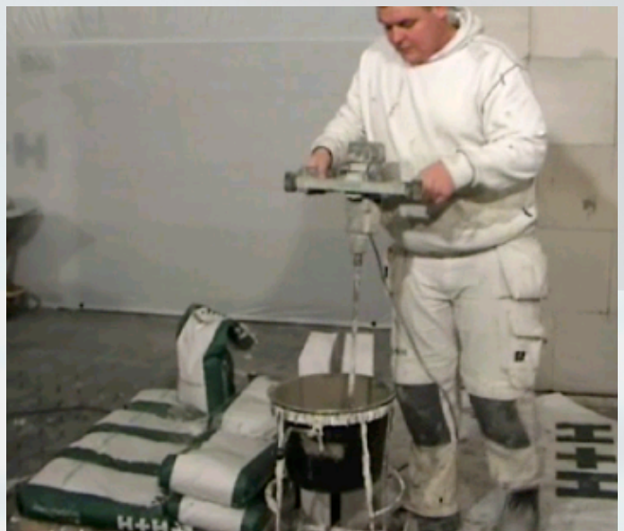
Lím og vatn hrært með hrærivél. Til að koma í veg fyrir að límið kekkist ætti að láta hrært lím bíða í 5 mínútur og hræra það svo upp aftur fyrir notkun.
