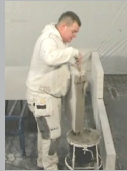
Multipladen® hleðslusteinn er settur á kantinn á límfötunni, lím er borið á botnfúguna.
