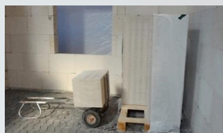
Multipladen® hleðslusteinunum neðst á brettinu er komið í þægilega hæð með hjálp hjólakerru sem passar inn á milli H+H bretti-sins og hleðslusteinanna.
