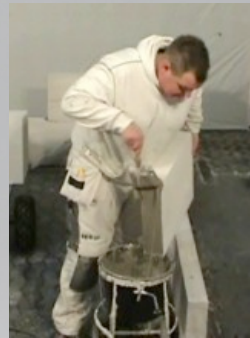
Multipladen® hleðslusteinn er settur á kantinn á límfötunni, lím er borið á hliðarfúguna.
